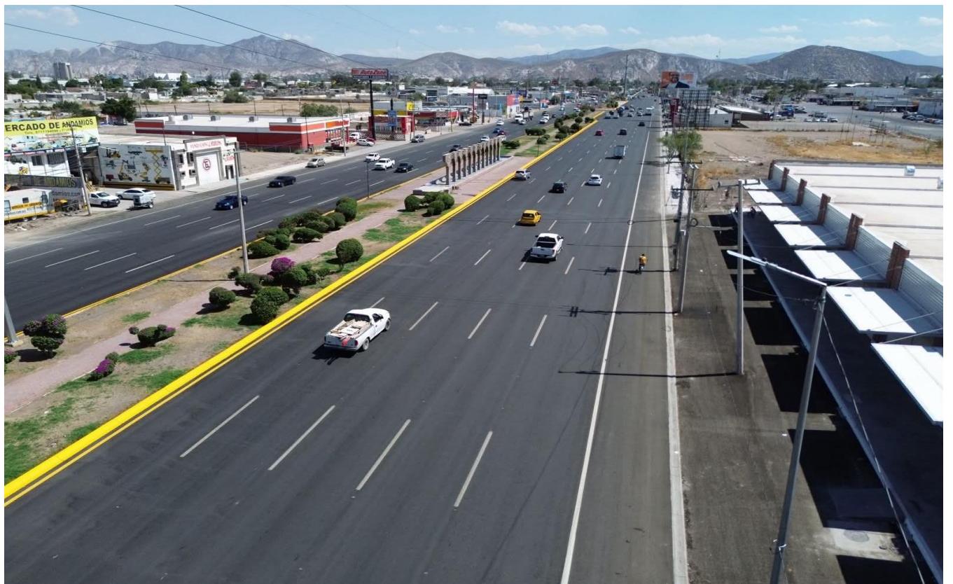
Reconstrucción integral del Blvd. José Rebollo Acosta
